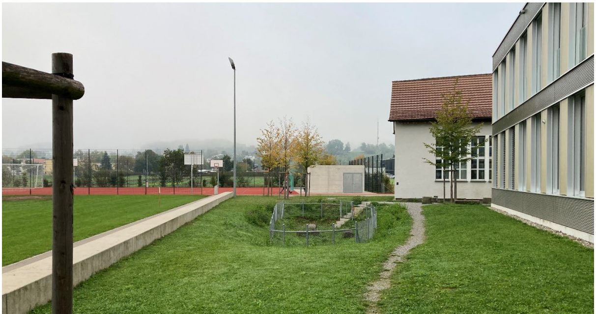
Abb. 3.14 Unzugängliche Retentionsanlage S
