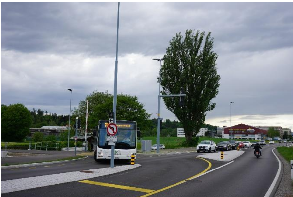
Abbildung 8: RVS-Massnahme LSA Klotenerstrasse
