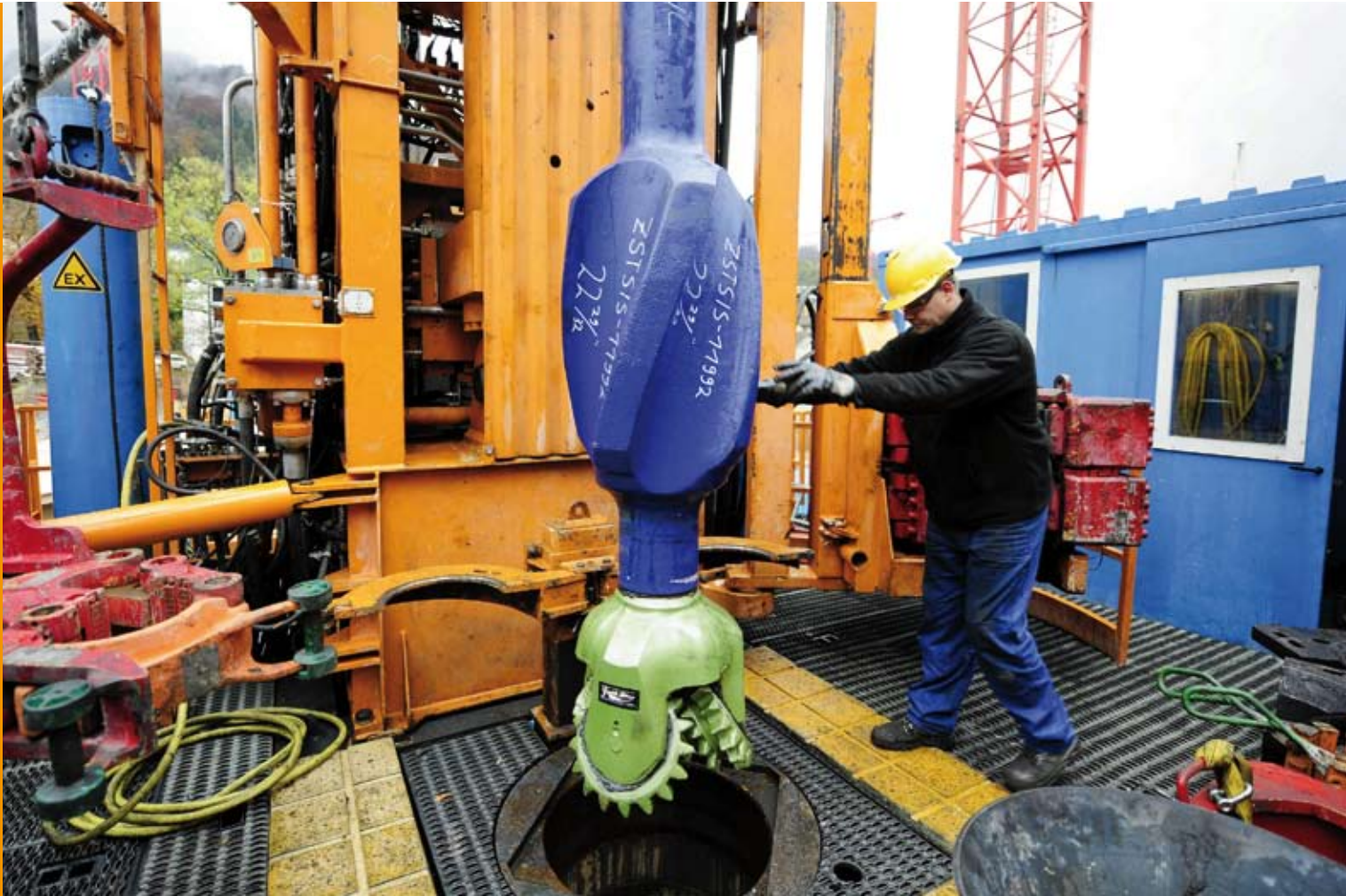
Tiefbohrung beim Geothermieprojekt im Triemli-Quartier, Zürich
