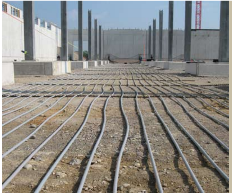
Erdregister unter Bodenplatte
