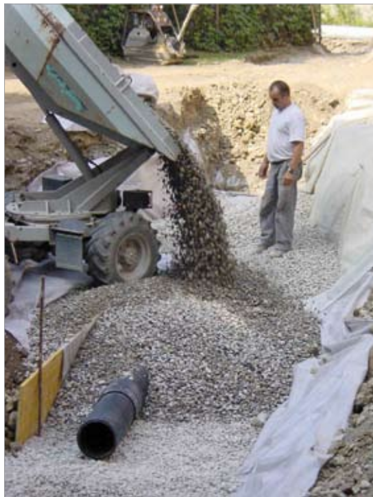
Bau einer Versickerungsanlage für die Rückgabe von abgekühltem Grundwasser
