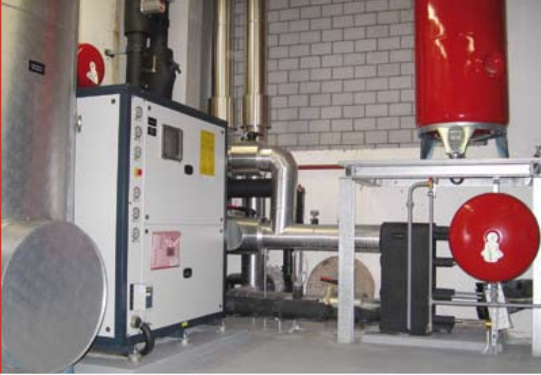
Grundwasser-Wärmepumpenanlage
